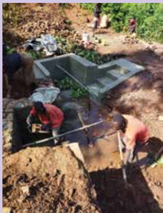
Gradnja enega izmed 4 novih vodnjakov v Gitegi v Burundiju.
