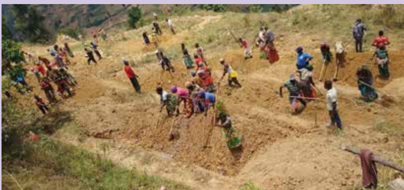
Starši pri izgradnji 5 hektarov za preprečevanje erozije zemlje v Ruandi.
