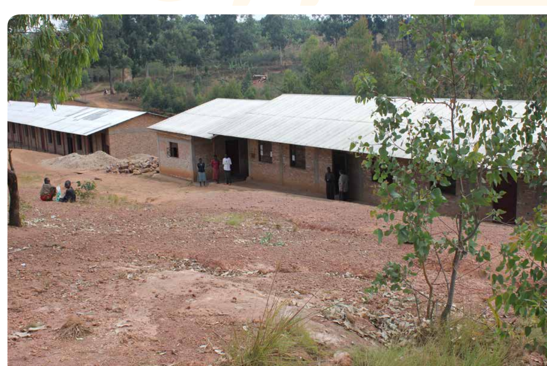
Novozgrajena srednja šola za 600 mladih v Mbiriziju (Burundi).
