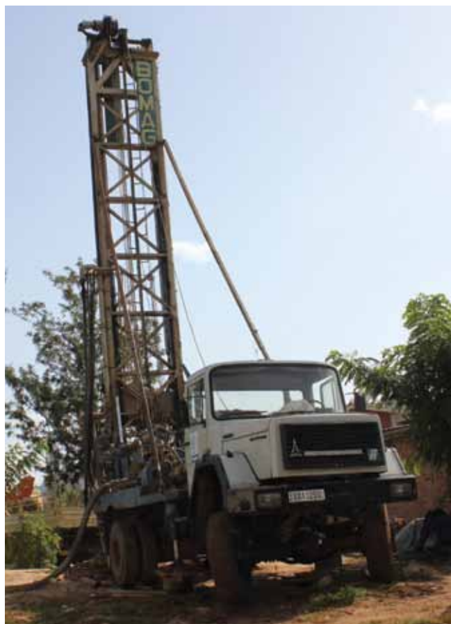
Gradnja vodnjaka v Kigaliju
