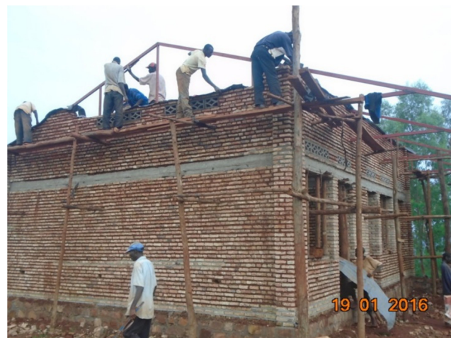
Gradnja zbornice za učitelje ... zraven zgradbe šole.
