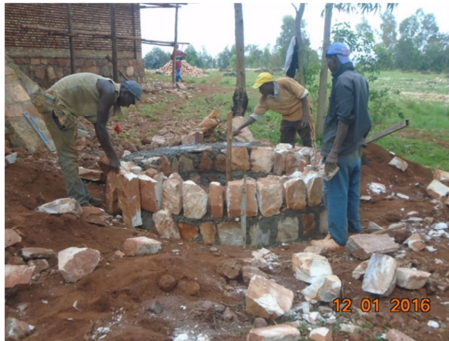
Gradnja dveh podstavkov za cisterno za vodo.
