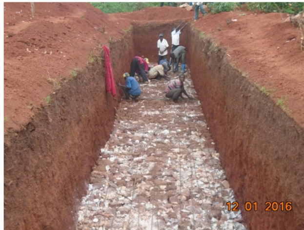
Gradnja septične jame za izgradnjo stranišč za dekleta in za fante.
