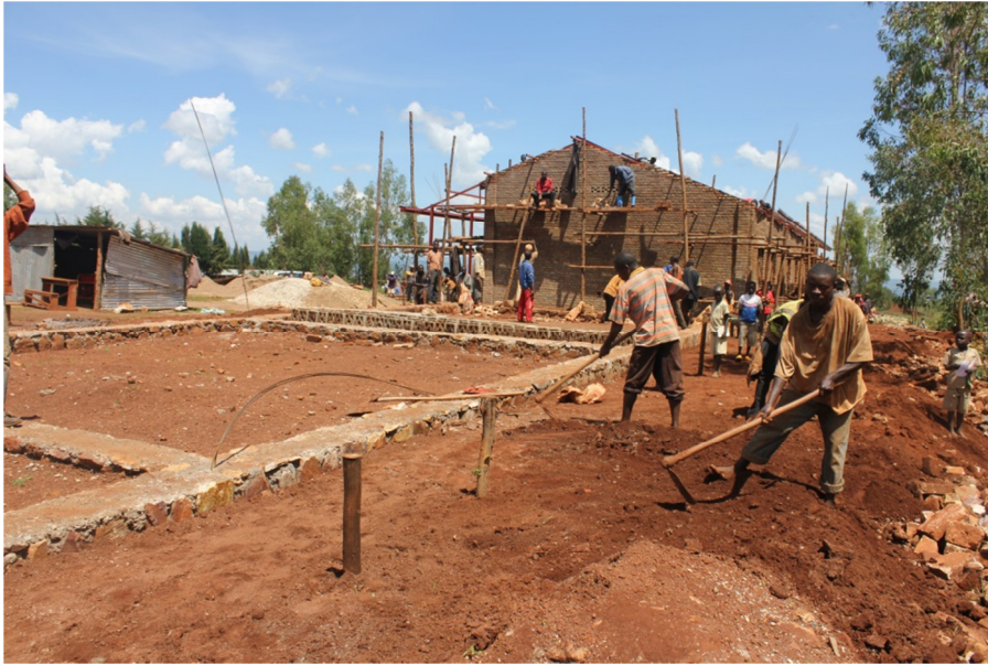
Gradnja prvega bloka s 6-imi učilnici in zgrajeni temelji za drugi blok šole s 6-imi učilnicami.
