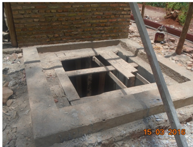
Kontrolno okno za septično jamo.
