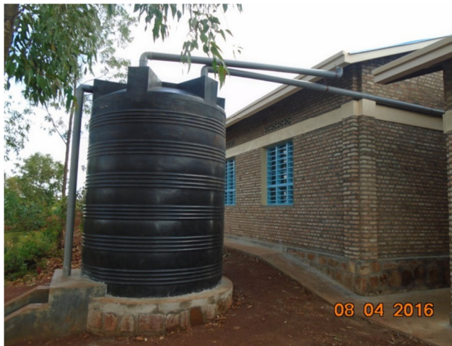
Namestitev dveh 10.000 l cistern ob zgradbo šole za zbiranje deževnice.
