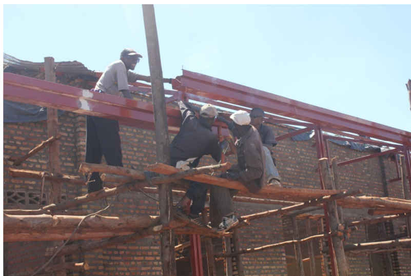
Nameščanje ostrešja in žlebov na zgradbo šole.
