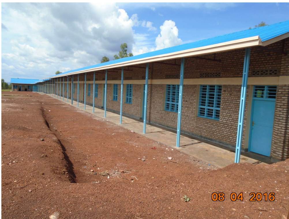
Novozgrajena šola z 12 učilnicami in zbornico v Nyangungu.
