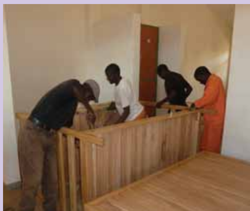
Domačini pri montaži pogradov v internat za dekleta v okviru novozgrajene srednje šole v Kasungu - Malaviju
