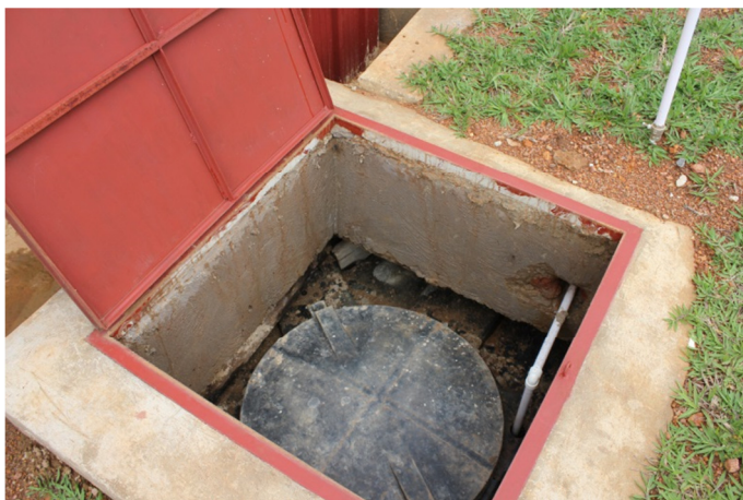
2 10.000 litrski cisterni sta vgrajeni v zemljo, deževnica prihaja do njiju po žlebovih, vodo črpajo do WC-je z električnim motorjem.
