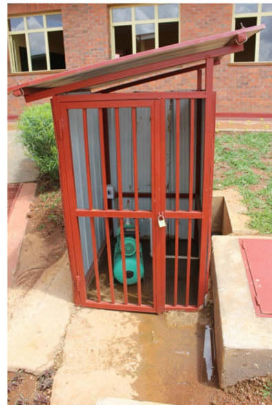
2 10.000 litrski cisterni sta vgrajeni v zemljo, deževnica prihaja do njiju po žlebovih, vodo črpajo do WC-je z električnim motorjem.
