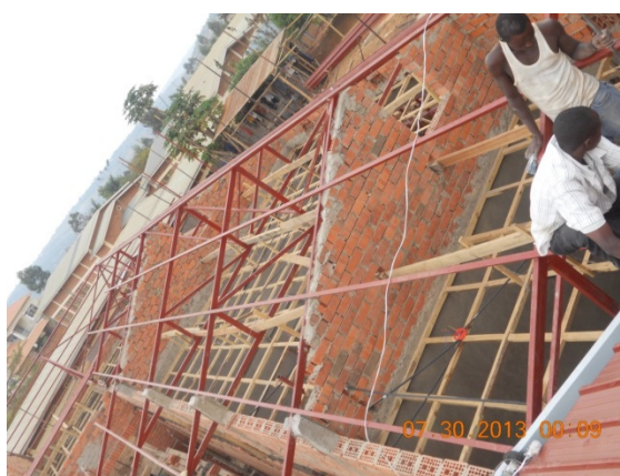
Varjenje železne konstrukcije za okna in vrata ter za konstrukcijo za streho za šolo.
