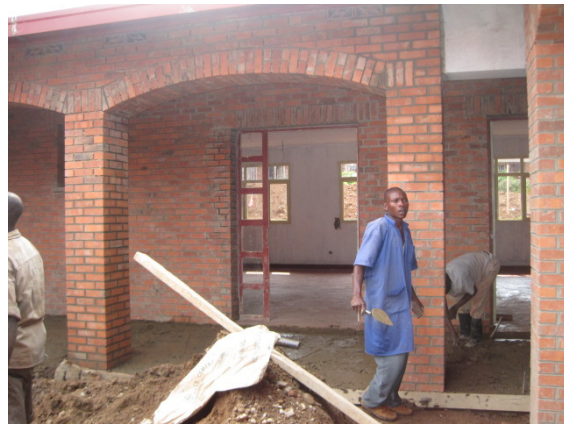
Zaključna dela pri šoli.
