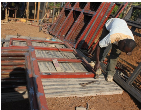
Varjenje železne konstrukcije za okna in vrata ter za konstrukcijo za streho za šolo.
