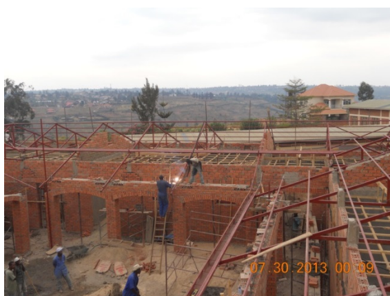
Varjenje železne konstrukcije za okna in vrata ter za konstrukcijo za streho za šolo.
